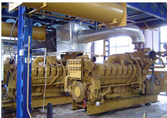
Photos 3 : Groupes électrogènes CATERPILLAR
